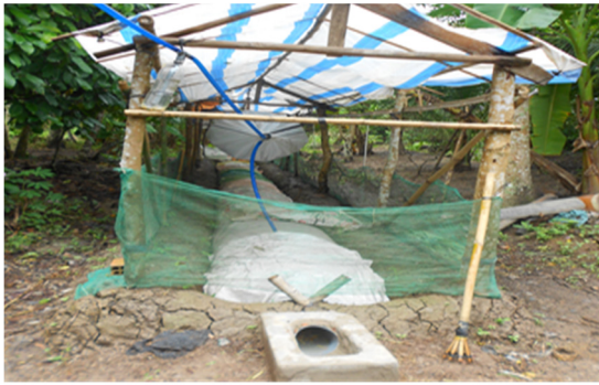
Hình 1b: Túi ủ biogas được nông hộ sử dụng ở xã Mỹ Khánh, huyện Phong Điền, Thành phố Cần Thơ
