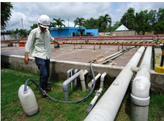
Hình 1: Thu thập vi sinh vật tại bể bùn hoạt tính của hệ thống xử lý nước thải
